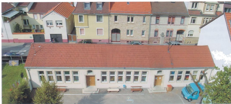
Oben: Gesamtansicht Nordwest
